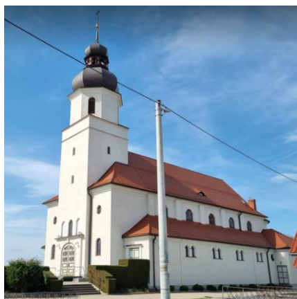
Fotografia 4. Widok na Kościół pw. św. Józefa Robotnika w Węgrach.
