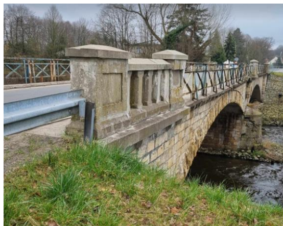
Fotografia 15. Widok na most drogowy w Turawie.
