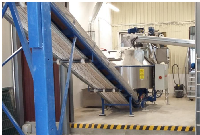
Zabudowa urządzeń linii technologicznej przerobu osadów
