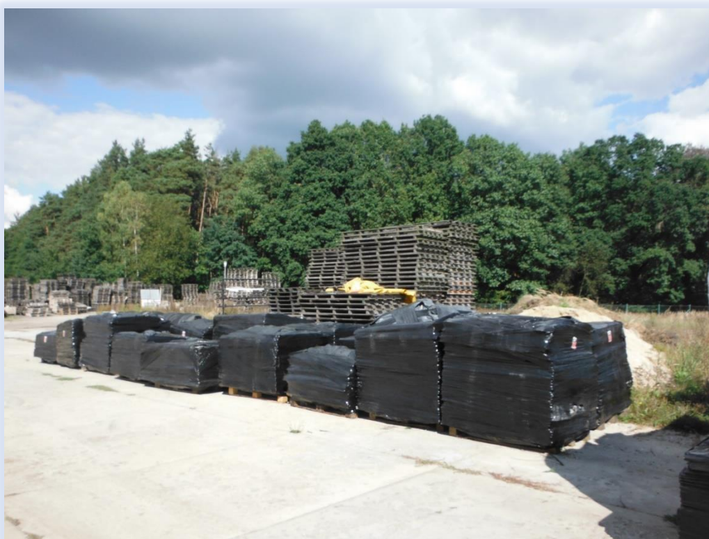
Przygotowane odpady azbestowe do odbioru przez specjalistyczny podmiot w trakcie jednego z naboru wniosków na usuwanie azbestu
